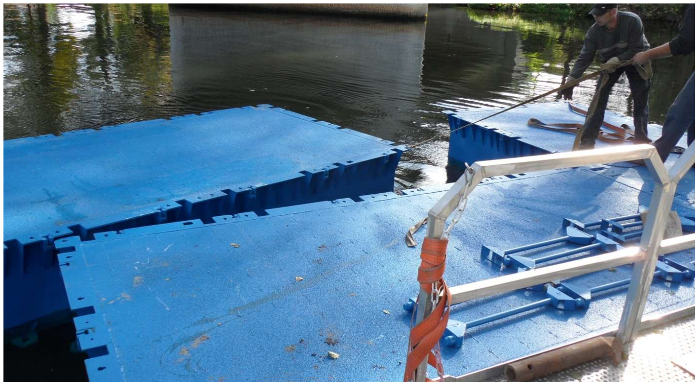
Positionierung der Einzelpontons auf dem Wasser
